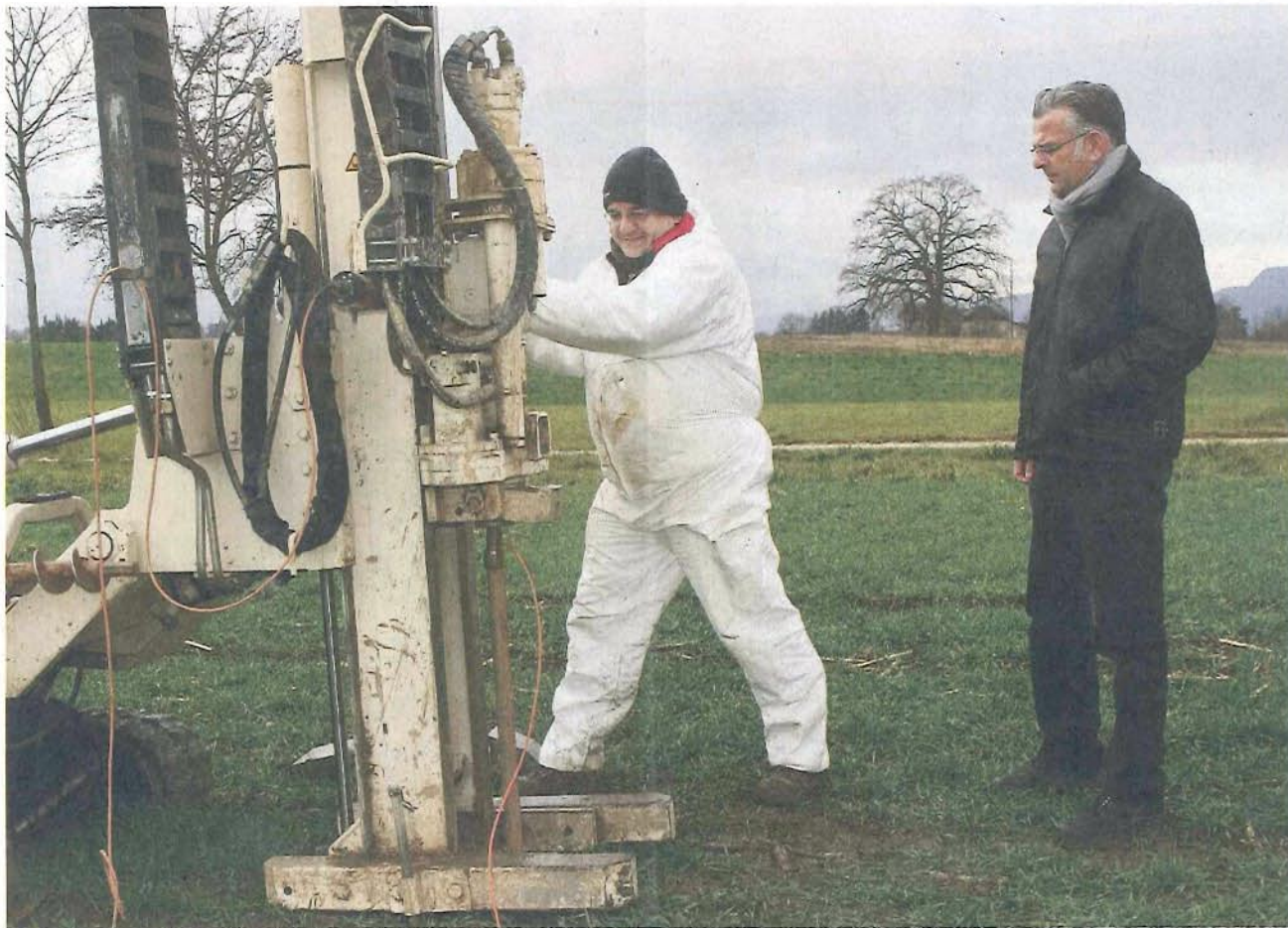
Martin Brehmer (r.), Leiter Abteilung Boden (Amt für Umwelt), und Mike Schlorke, Geräteführer bei der deutschen Altlastenspezialistin geo-log. Hier wird die Bodenbeschaffenheit geprüft.
